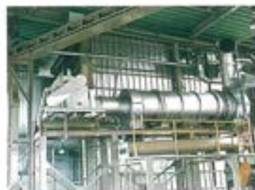
育苗床土生産プラント
